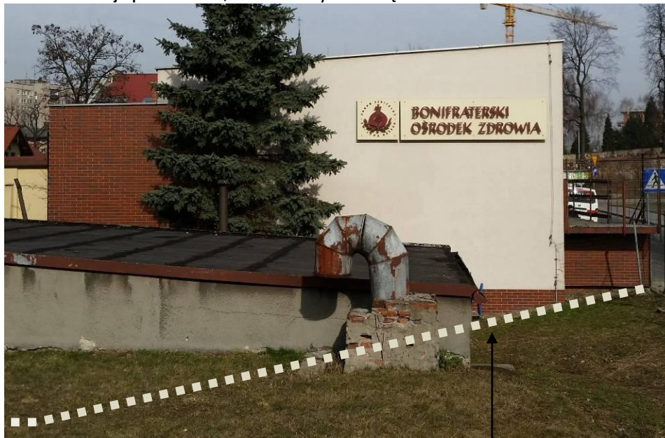
Fot. 5 Elewacja południowa , ściana szczytowa części B
