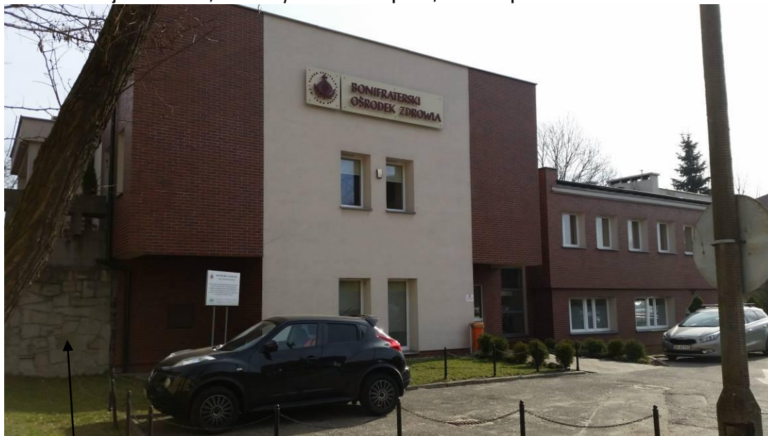
Mur oporowy utrzymujący naziem od strony ulicy Wróblewskiego.
