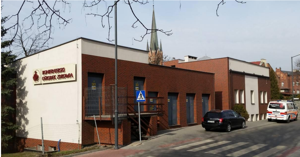
Część B , stacja Trafo
