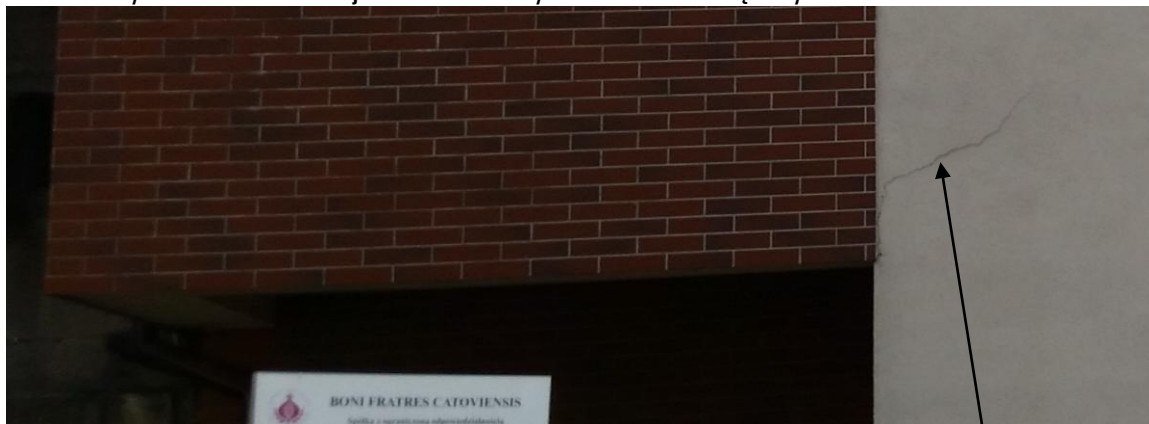
Zarysowanie w rejonie utwierdzenia wspornika
