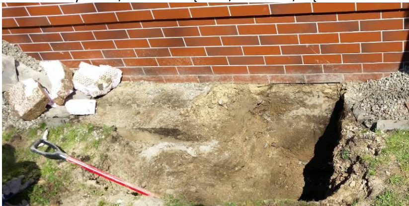
Fot. 11 Odkrywka 4, ściana zewnętrzna, zachodnia, część B.
