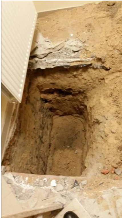
Fot. 9 Odkrywka 2, pomieszczenie techniczne, pasmo klatki schodowej, pod wejściem, część A.
